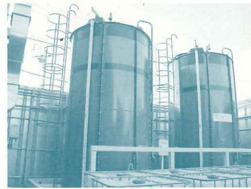
液体肥料貯蔵タンク
