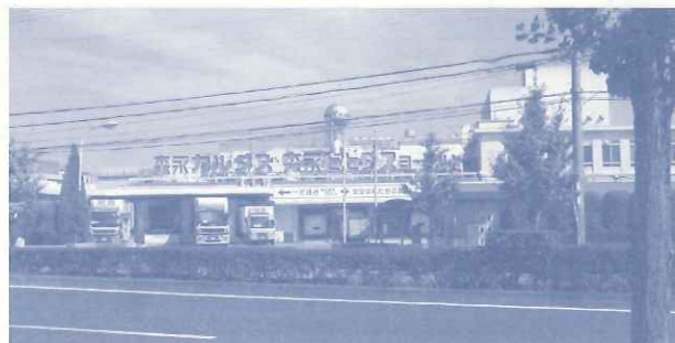
兵庫県西宮市の国道沿いにある森永乳業近畿工場は丸い貯水タンクが印象的
